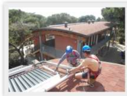
INSTALLAZIONE PANNELLI SOLARI
