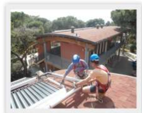
INSTALLATION VON SONNENKOLLEKTOREN
