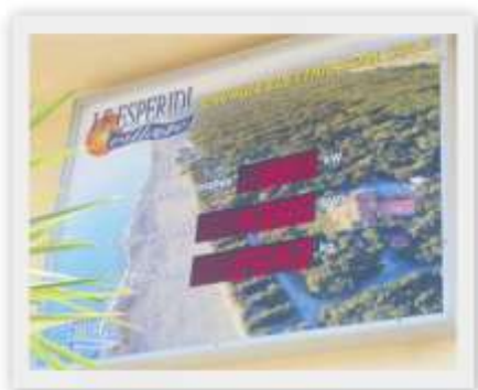
ZÄHLER FÜR DIE PRODUZIERTE SOLAR-ENERGIE
